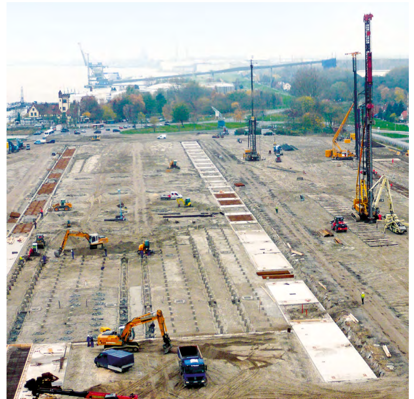
Monopile-Werk „Steel Wind“, Nordenham: 2.950 Simplexpfähle
