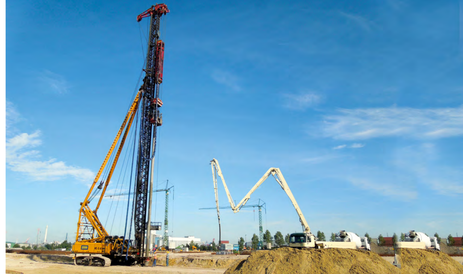
Containerpackstation Wollkämmereistraße, Hamburg: 1.400 Simplexpfähle
