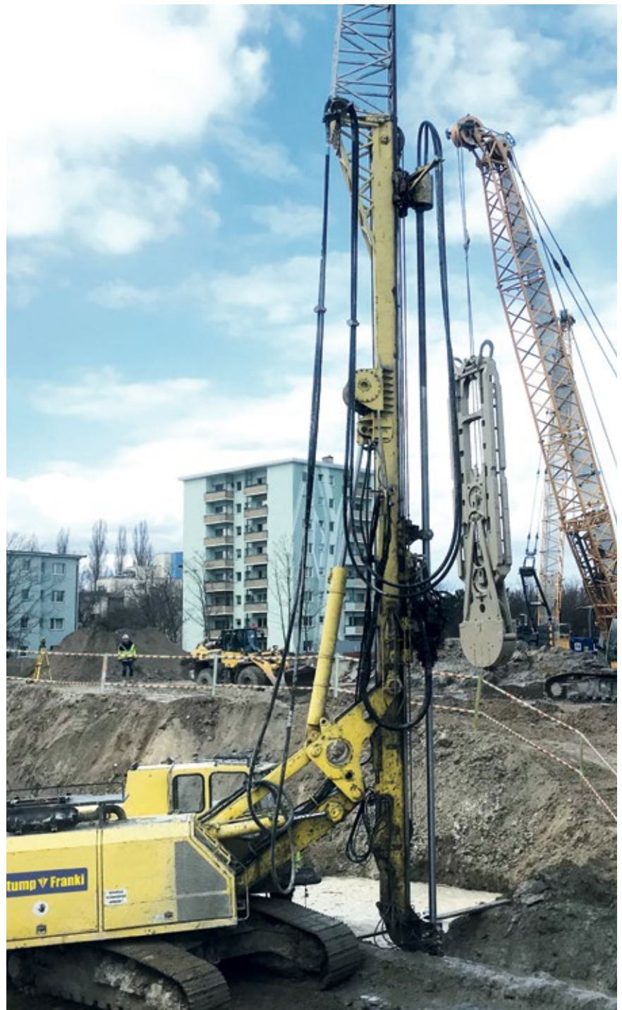
Herstellung von DSV-Dichtsohle und Schlitzwänden
