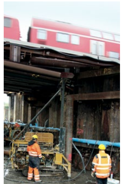
Ausführung unter beengten Platzverhältnissen möglich.
