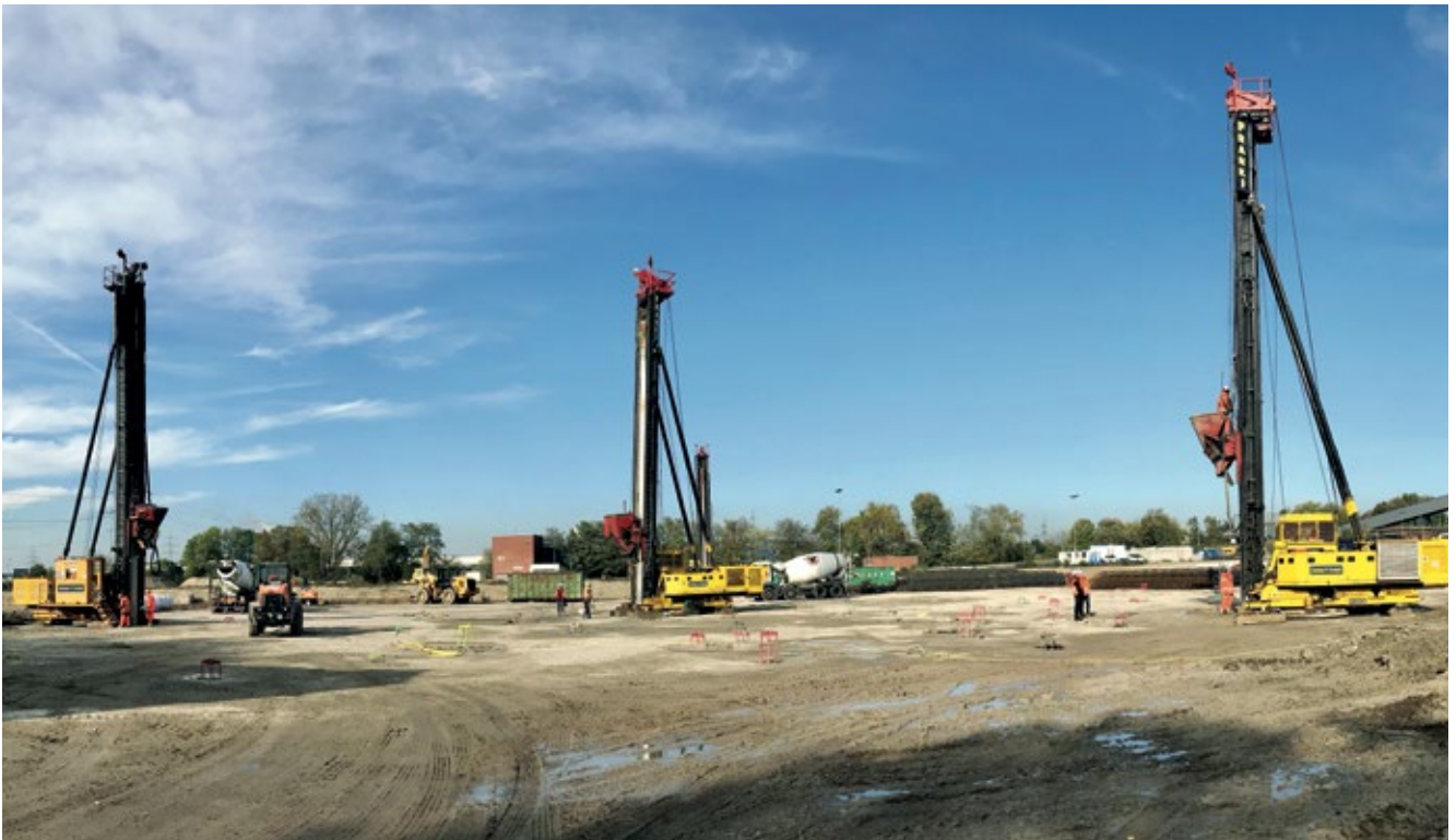
Mehrere FRANKI-Rammen kommen in Offenbach zum Einsatz.
