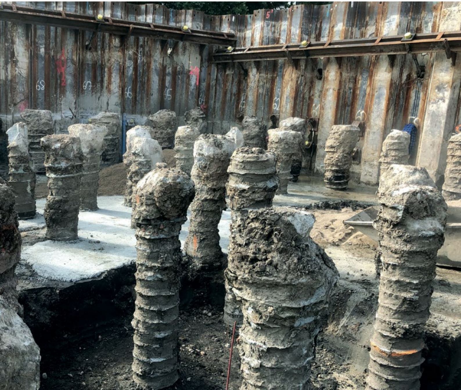
Freigelegte Pfahlköpfe der Atlaspfähle vor dem Kappen.
