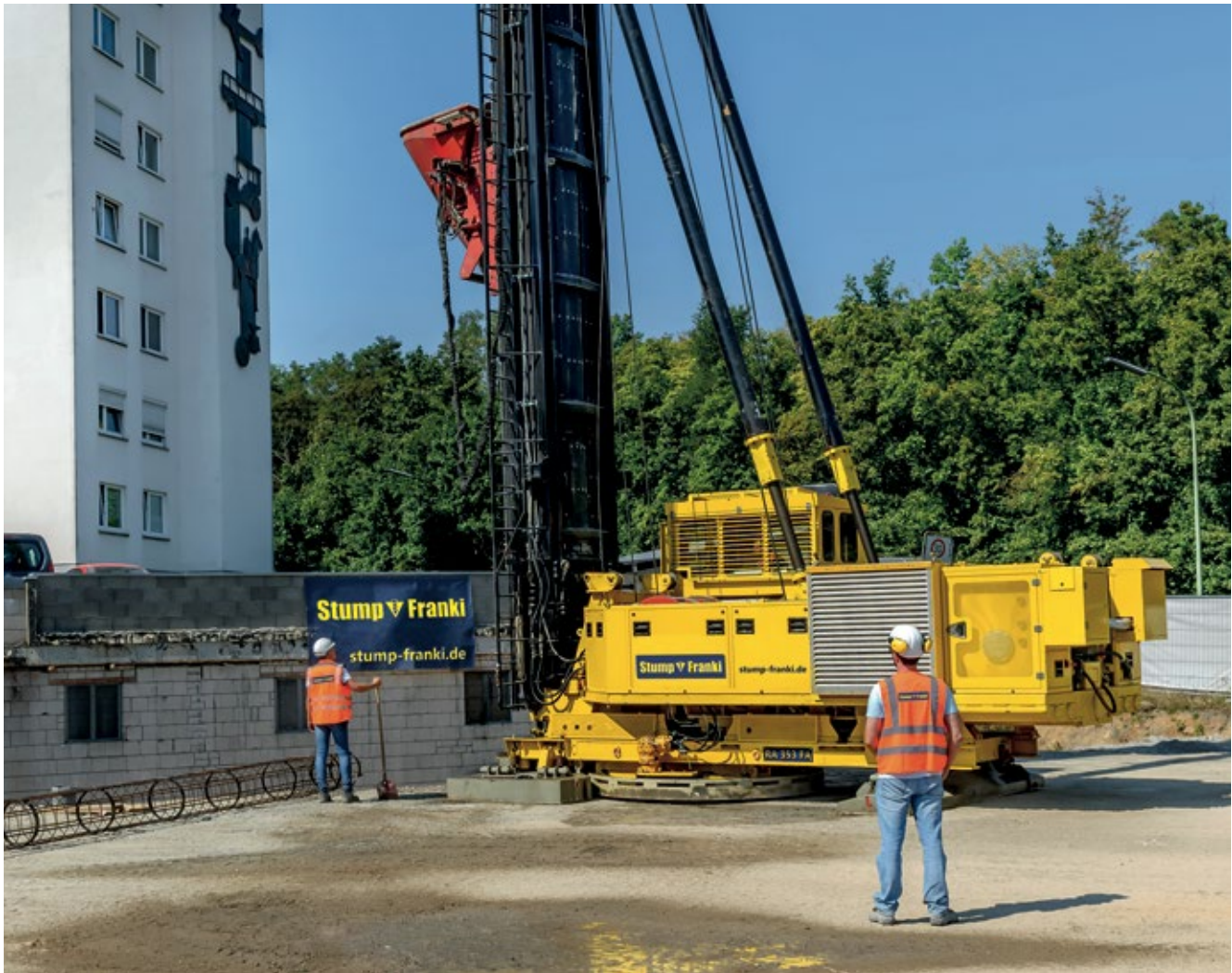
Herstellung von Frankipfählen NG® neben einem Bestandsgebäude.
