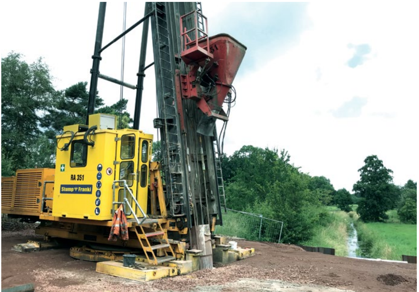
Herstellung der Frankipfähle NG® mit einer Neigung von 6:1.
