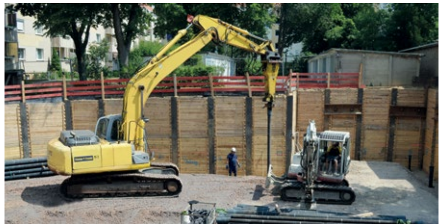
Einrammen von HLV®-Pfählen.
