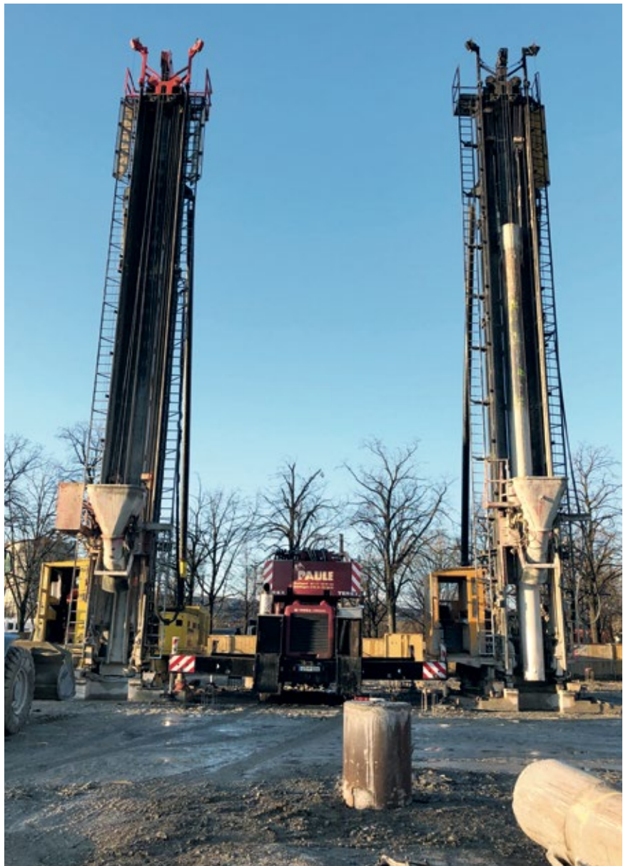
Zwei FRANKI-Rammen im Einsatz mit Probepfahl im Vordergrund.
