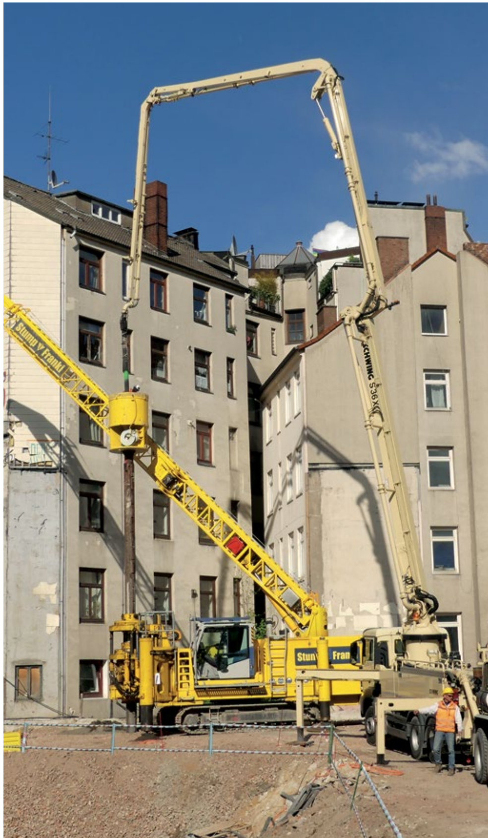
Pfahlherstellung direkt vor Bestandsgebäuden.
