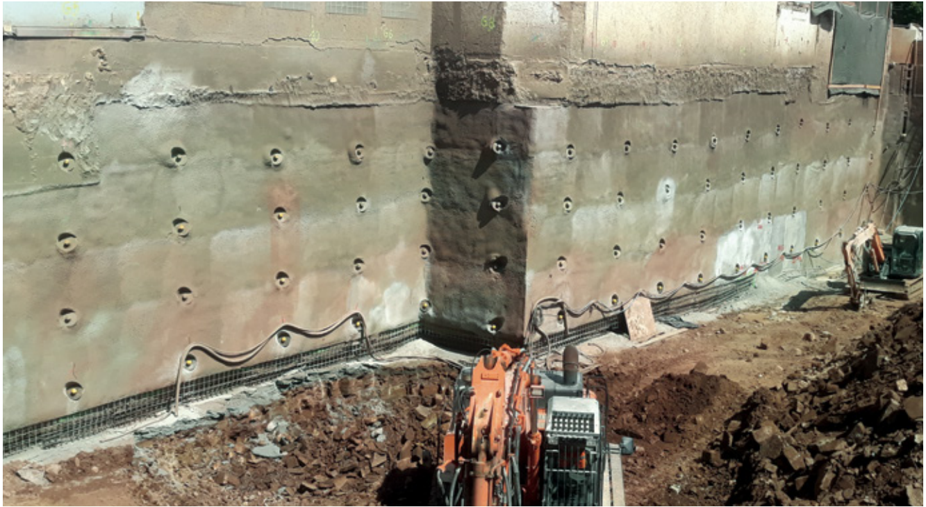
Unterfangung, Spritzbeton und Rückverankerung.
