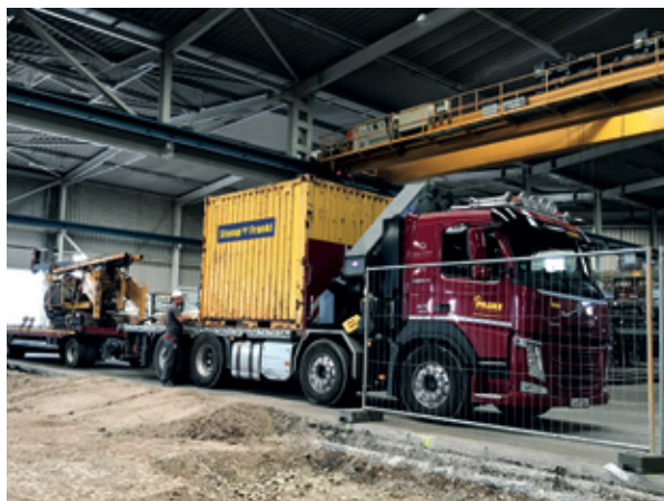
Maßarbeit schon beim Transport und Aufbau des Rammgerätes.
