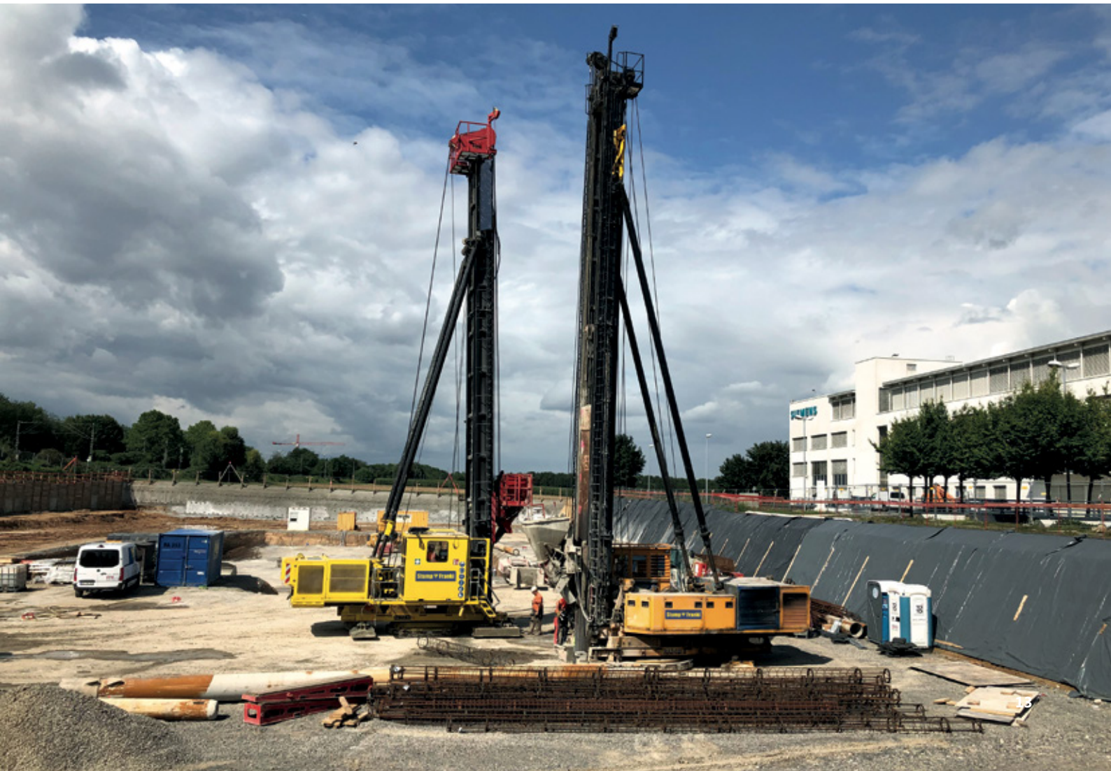
Zwei FRANKI-Rammen neben einem Bürogebäude im Einsatz.
