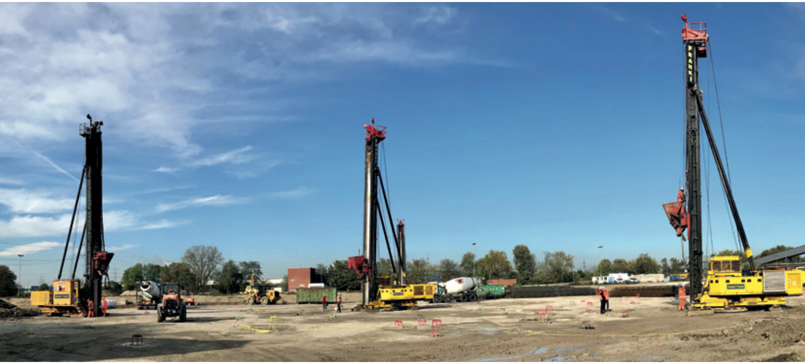
Drei FRANKI-Rammen in Herne im Einsatz.
