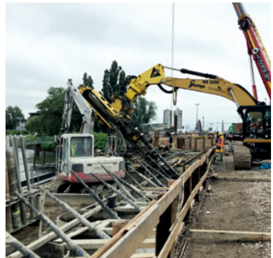
Bohrbagger am Hafenbecken im Einsatz.
