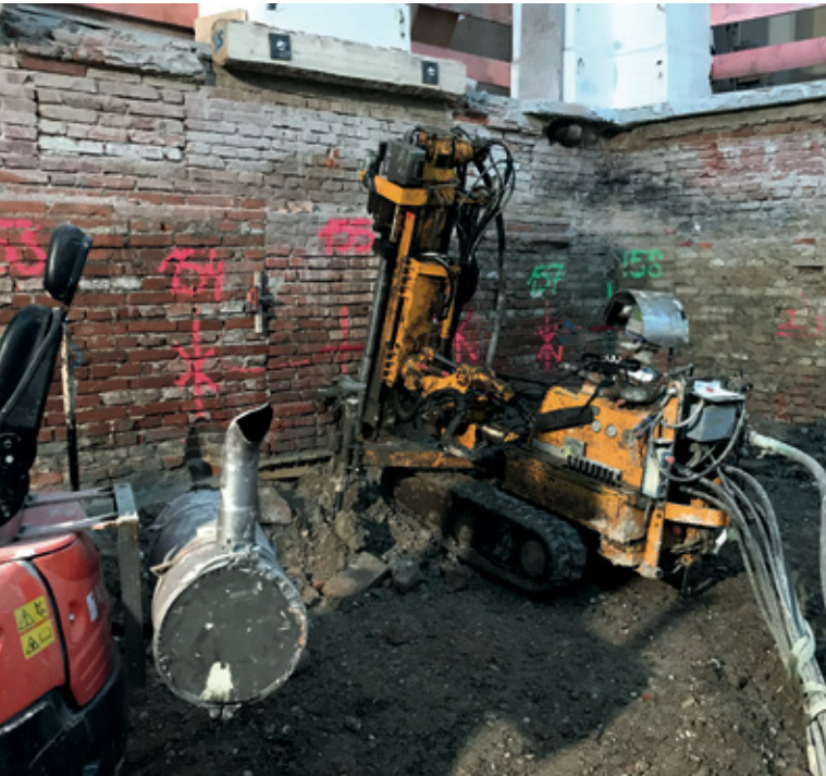
Unterfangung der Fundamente von tragenden Wänden.
