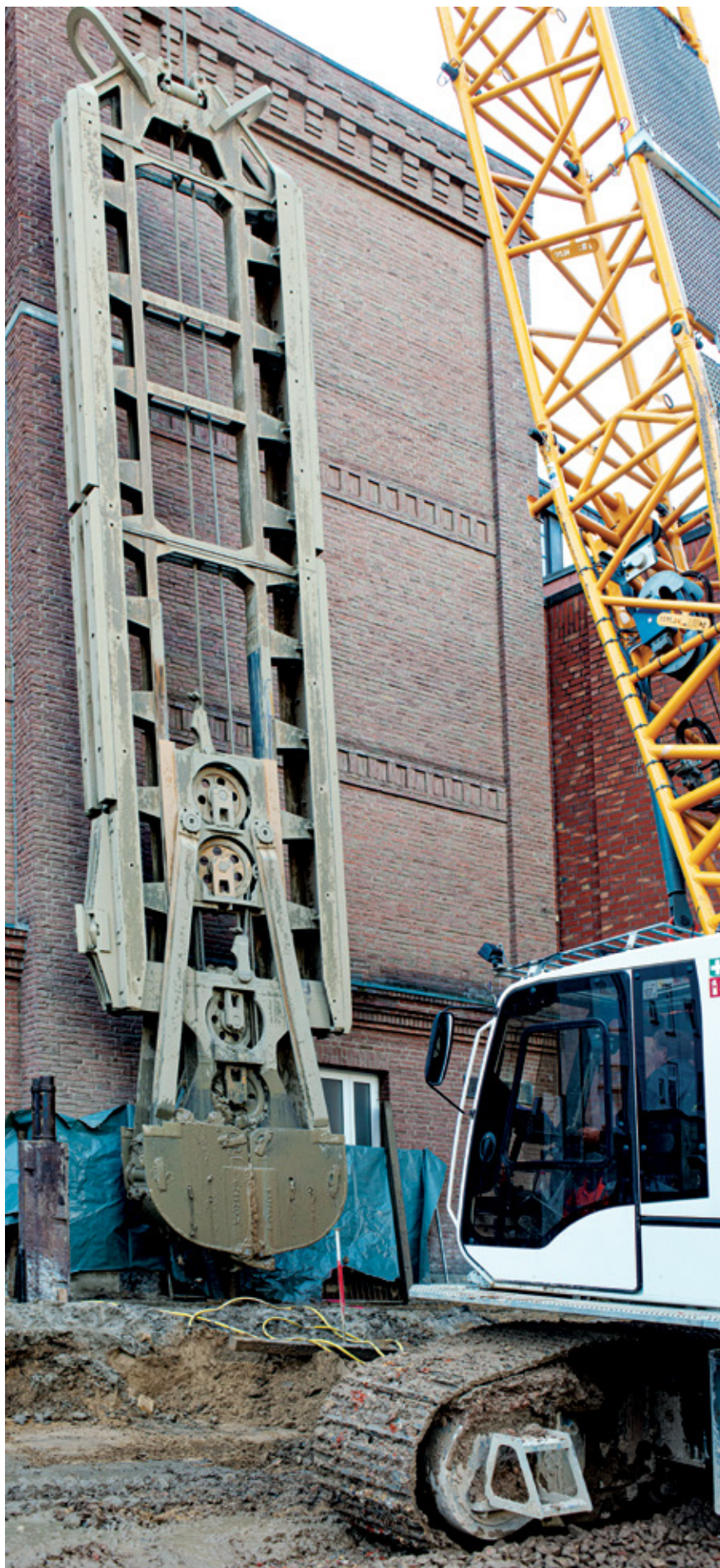
Schlitzwandgreifer direkt vor einem Bestandsgebäude.
