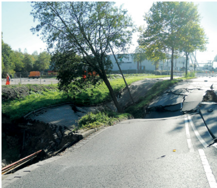
Die abgesackte Fahrbahn der Emscherallee in Dortmund Huckarde.
