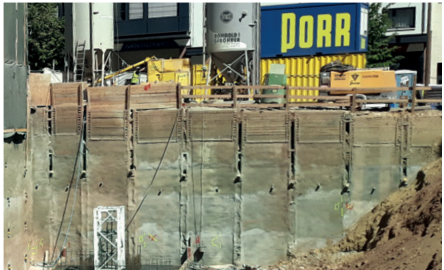
Rückverankerte Trägerbohlwand an der Poststraße.
