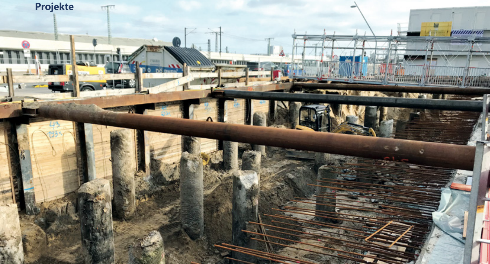
Innenaussteifung zur U-Bahn-Trasse.
