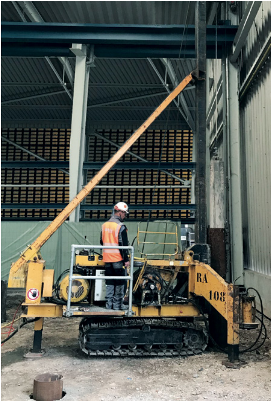
Ausführung mit Innenrammung und E-Antrieb.
