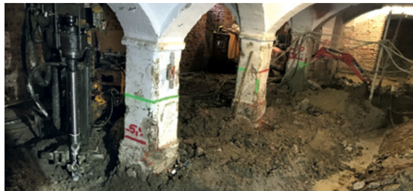
Oben: Blick in den Lichthof
