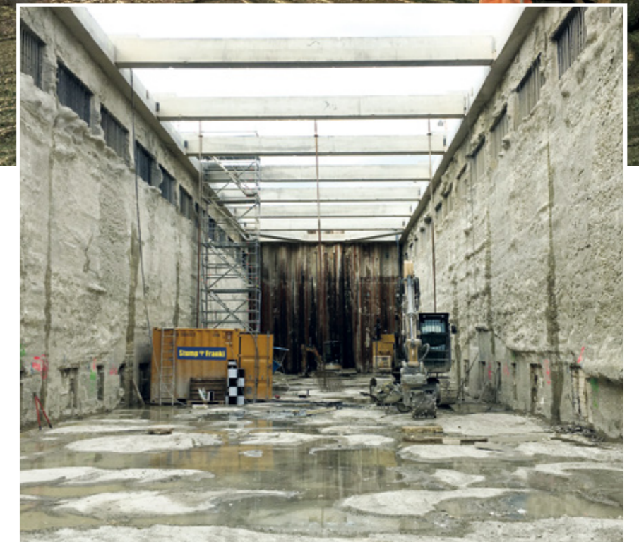
Gelenzte Trogbaugrube. ©Stump-Franki
