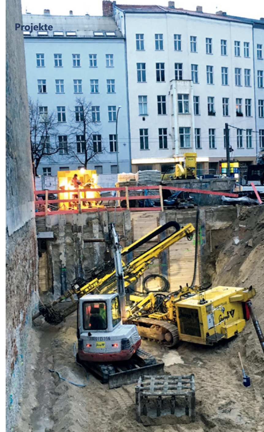
Ankerarbeiten ©Stump-Franki
