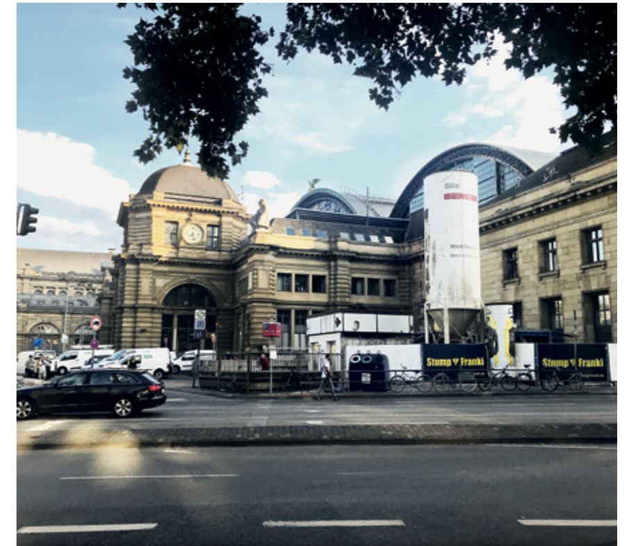
DSV-Baustelleneinrichtung vor dem Bahnhof. ©Stump-Franki
