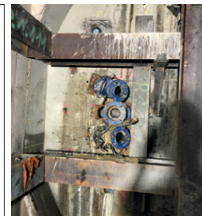
Engste Platzverhältnisse: Standrohr und Minipreventer ©Stump-Franki
