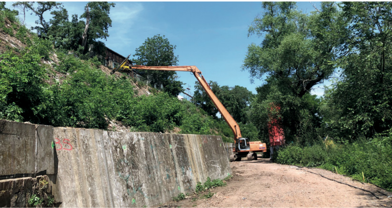
Langarmbagger im Einsatz ©Stump-Franki
