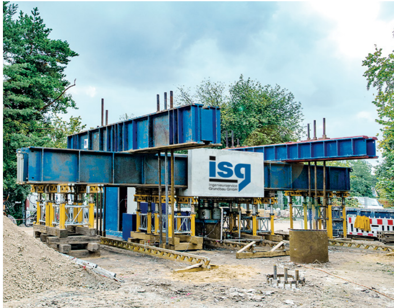
Belastung eines Großbohrpfahles bis 15 MN ©Stump-Franki
