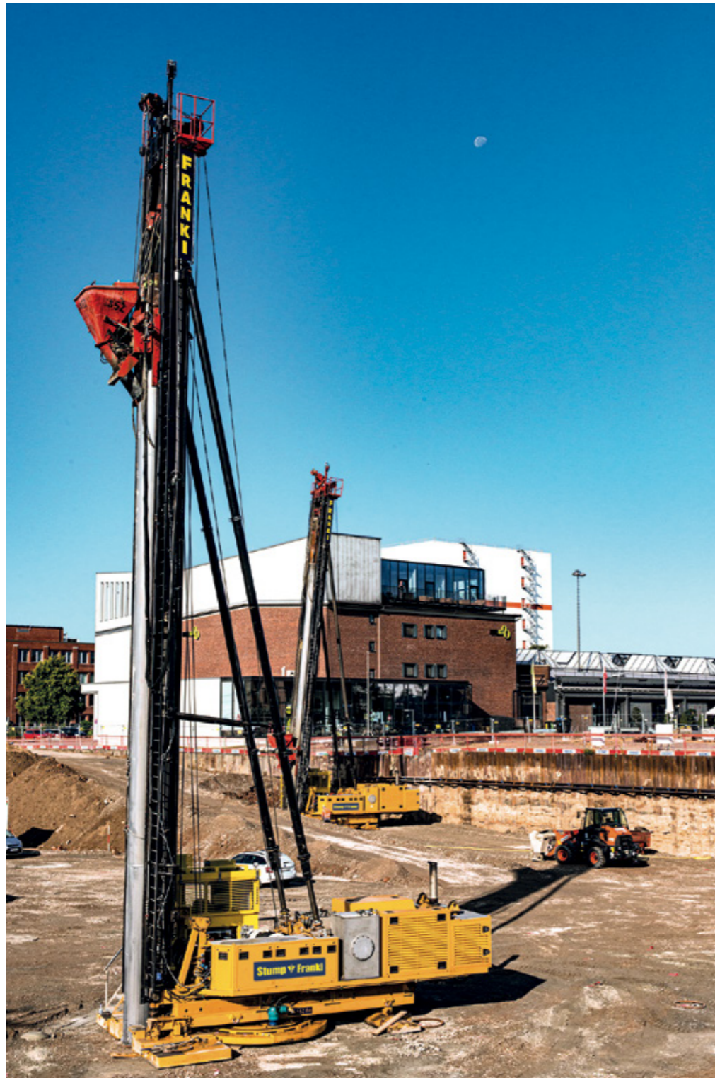
Zwei neue Franki-Rammen im Einsatz. ©Stump-Franki
