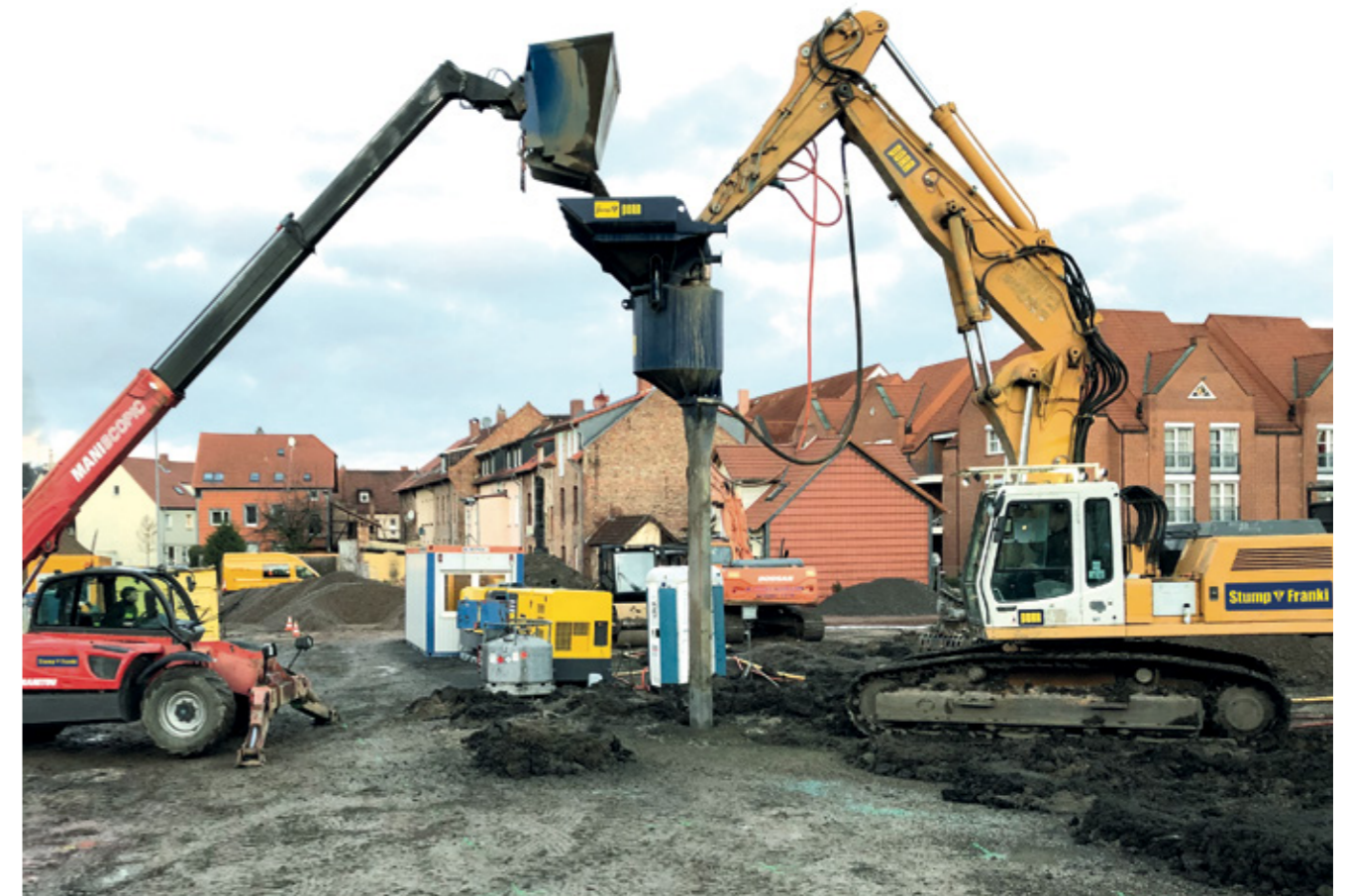
Herstellung der Rüttelstopfverdichtung © Stump-Franki
