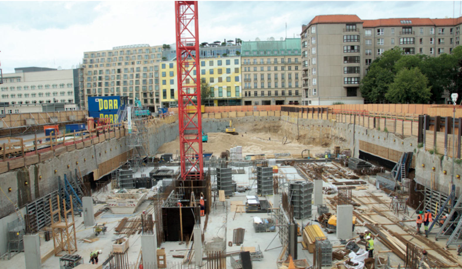
Blick in die fertige Baugrube. ©Stump-Franki
