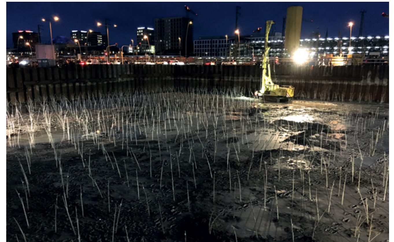
Das mit Injektionslanzen bespickte Baufeld bei Nacht. ©Stump-Franki
