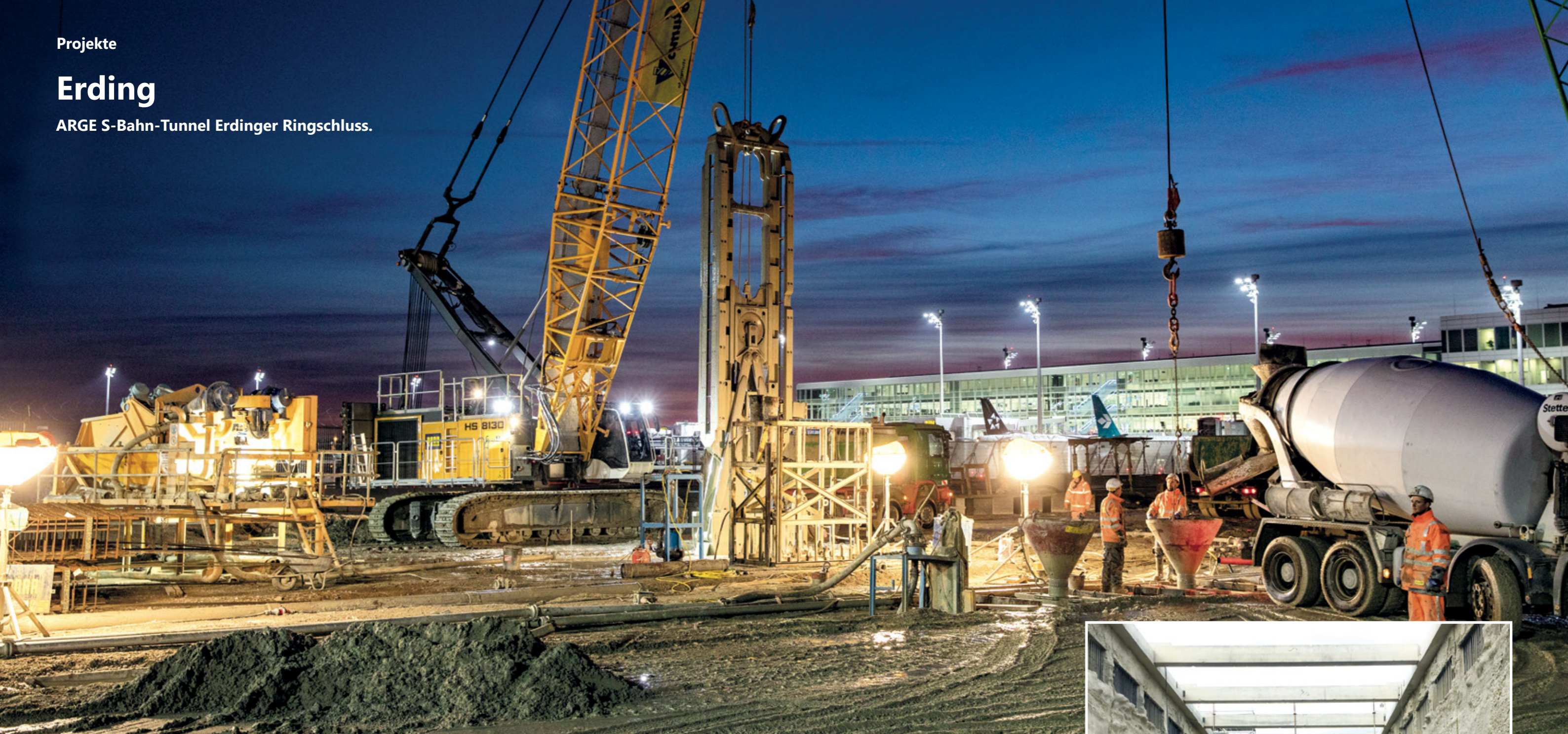
Betonieren einer Schlitzwand. ©Liebherr
