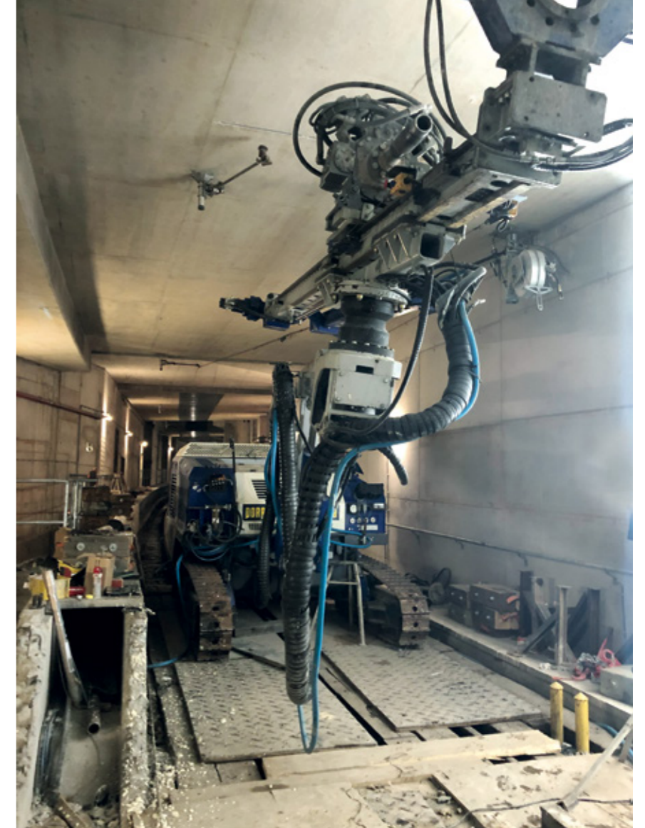
Speziell adaptierte Bohrlafette mit optimierter Kinematik ©Stump-Franki
