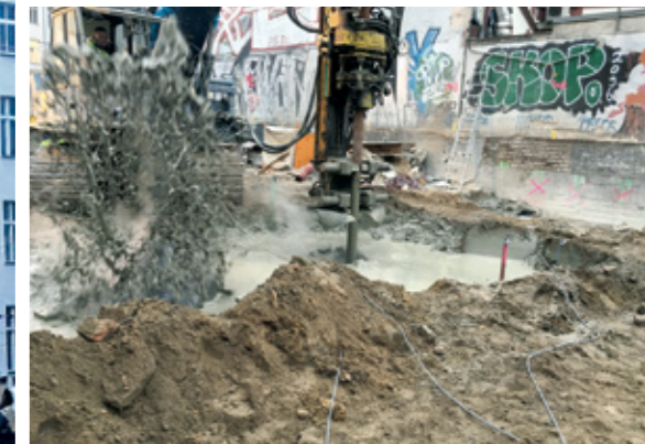
Herstellung der Dichtsohle ©Stump-Franki
