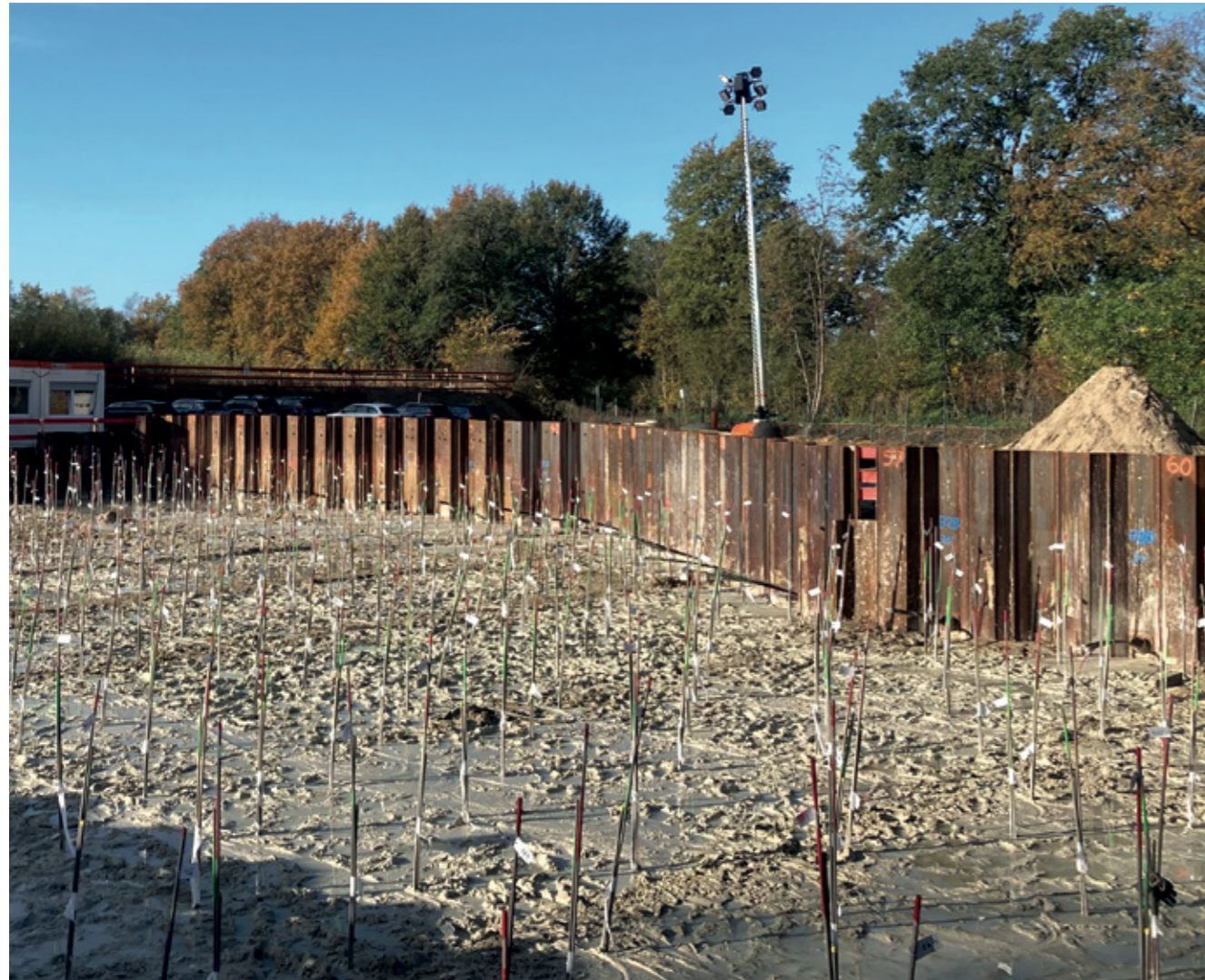
Baufeld nach Einbau der Injektionslanzen
