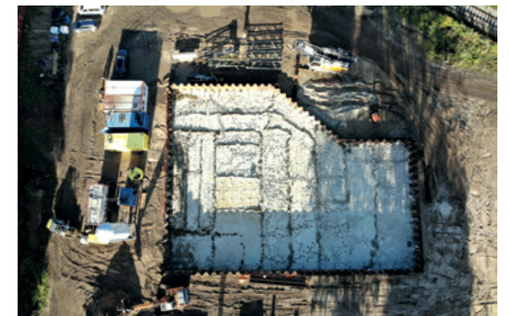
Fertige Weichgel-Injektionssohle
