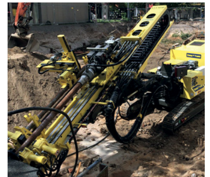
Bohrung mit Außenspülung für eine geplante Rückverankerung.
