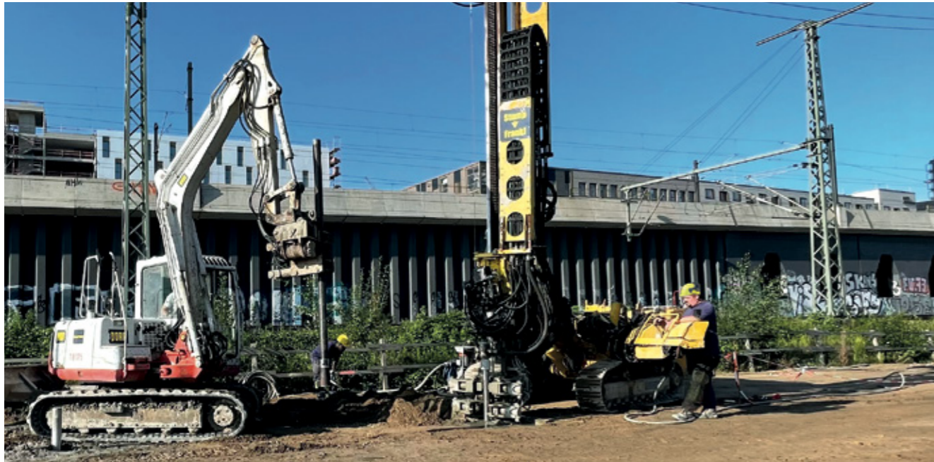
Bohrung mit Außenspülung für Mikropfähle
