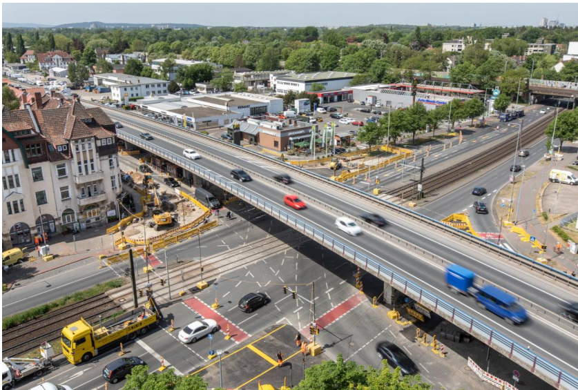
Die Brücke über die Hildesheimer Straße im Zuge des Südschnellweges. Foto © NLStBV Franz Bischof
