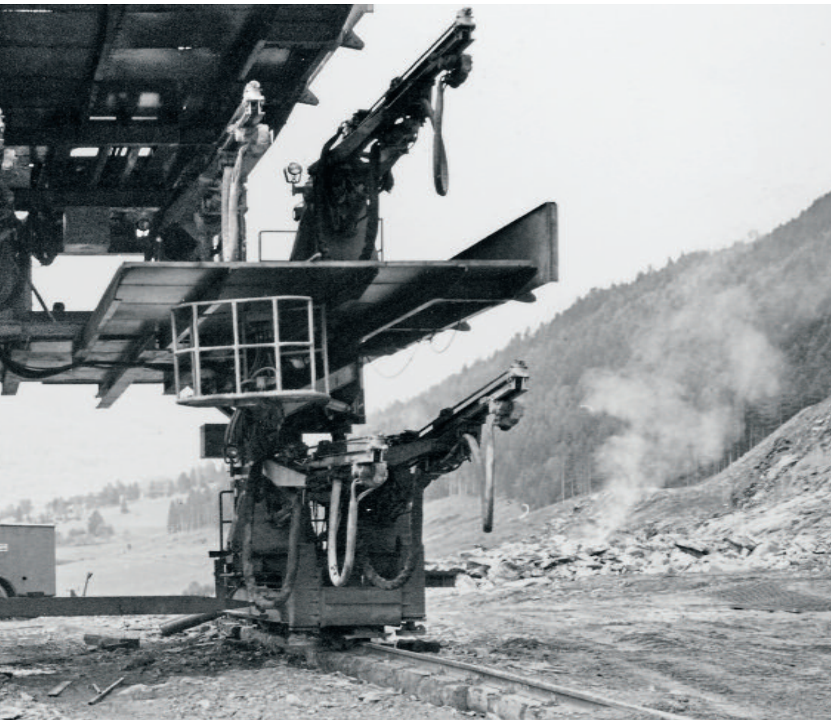
Eingesetzter Bohrwagen beim Tauertunnel in den 1970er-Jahren
