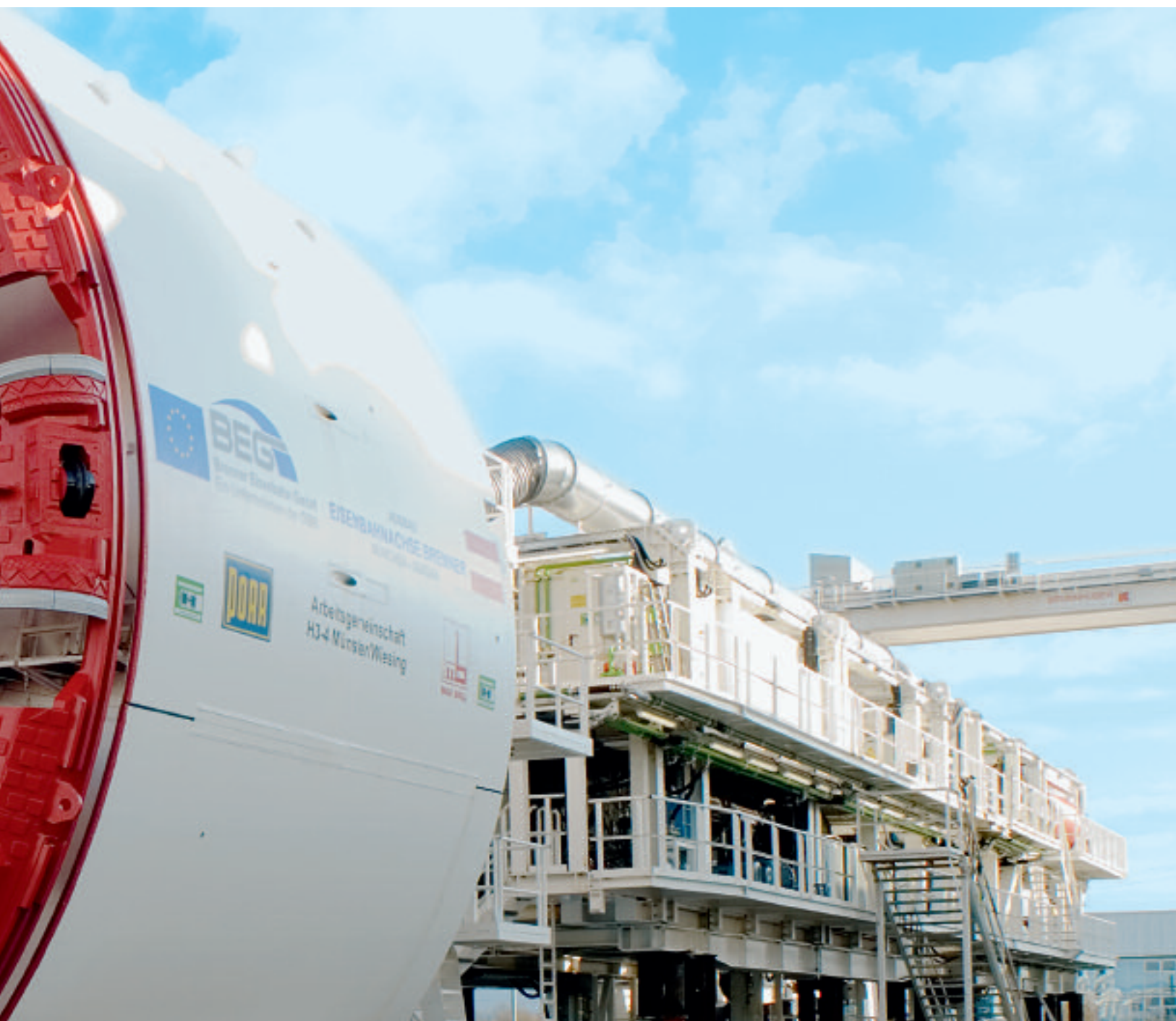
Hydroschild-Tunnelvortriebsmaschine beim Baulos Münster-Wiesing, Tirol 2007
