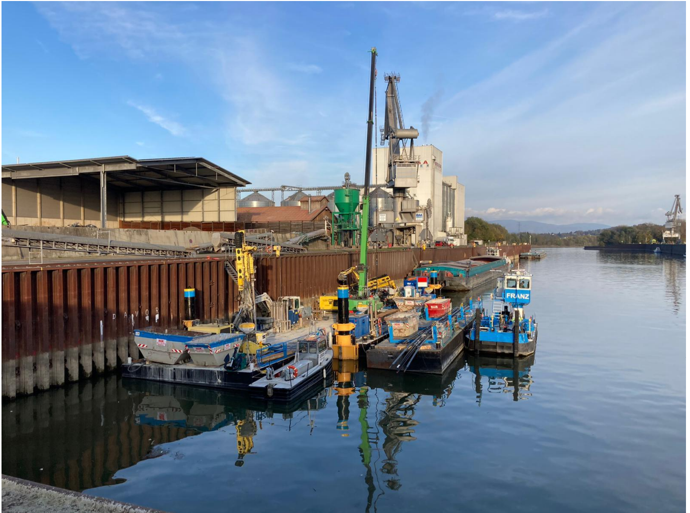
Die Spezialtiefbaustelle am Hafen in Straubing, auf der eine Spundwandverstärkung mit Verpressankern ausgeführt wird. © Stumpf-Franki
