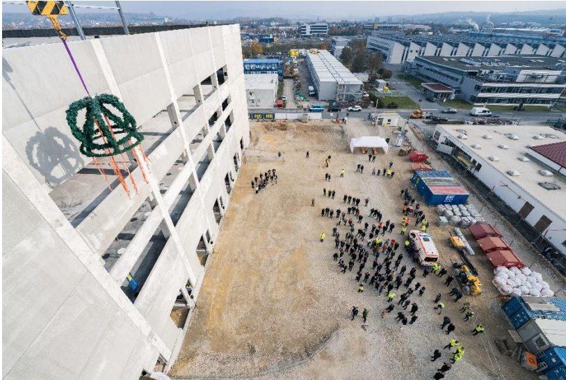
Bildunterschrift: Richtfest des High Energy Photonics (HEP) Center von Siemens Healthineers in Forchheim, Deutschland (Copyright: © Siemens Healthineers)
