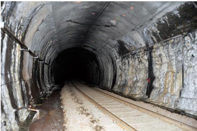
**Bildunterschrift:** Der derzeit 576 Meter lange Horschheimer Tunnel entspricht nicht mehr den heutigen technischen Anforderungen des Eisenbahnbetriebs (Februar 2012) © DB Netz AG
