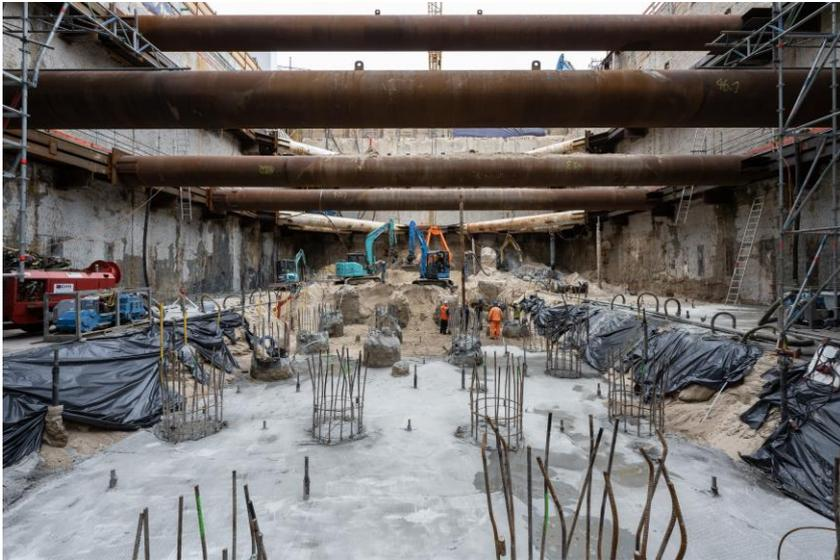
**Bildunterschrift 3:** Blick in die Baugrube: Die Stabilität erhält das spätere Hochhaus über eine knapp 4 m dicke Bodenplatte in Kombination mit 44 Großbohrpfählen und der bis zu 40 m tiefen Ortbetonschlitzwand.
