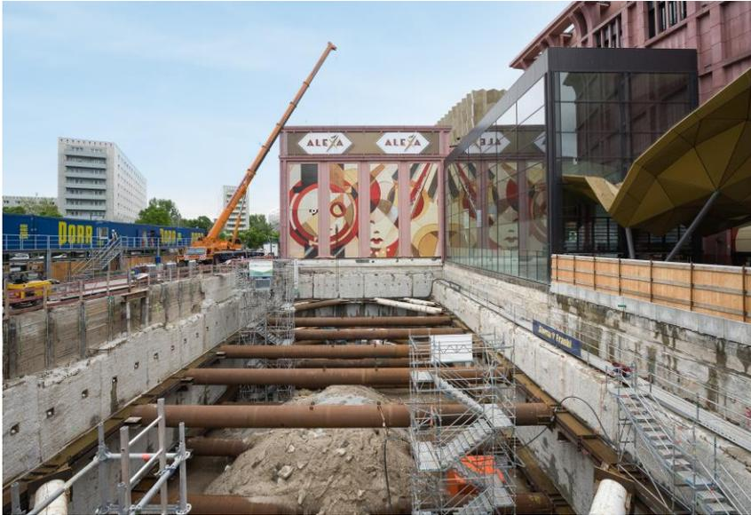
**Bildunterschrift 4:** Die Baugrube bietet mit einer Tiefe von insgesamt 21 Meter Platz für 4 Untergeschosse. Im 4. UG entsteht ein Übergang zur anliegenden, bereits bestehenden Tiefgarage der Alexa Mall.
