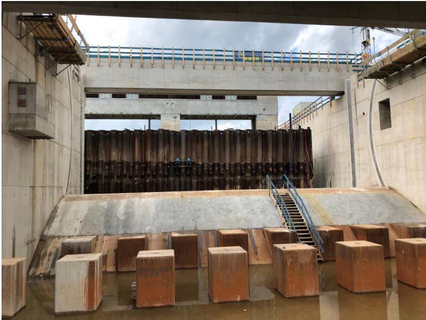
Bildunterschrift: Bis Mitte September wurden die Beton- und Erdarbeiten komplett abgeschlossen. Foto © PORR
