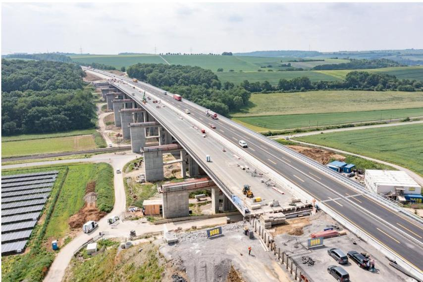
**Bildunterschrift:** Die Talbrücke Rothof (Fahrtrichtung Fulda) in Endlage nach erfolgreichem Querverschub. Foto © PORR / Martin Leissl
