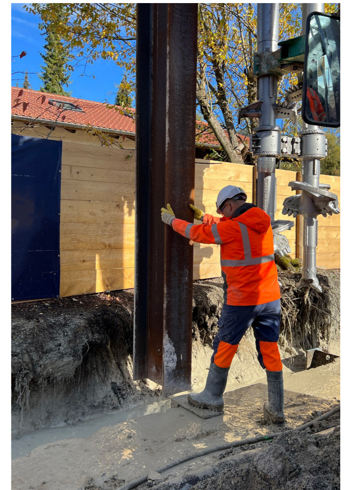
Einstellen von Tragelementen mit Kran und/oder Rüttler.
