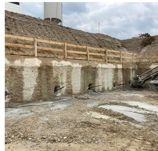
Eine Rückverankerung ist möglich und macht die Verbauwand besonders verformungsarm.
