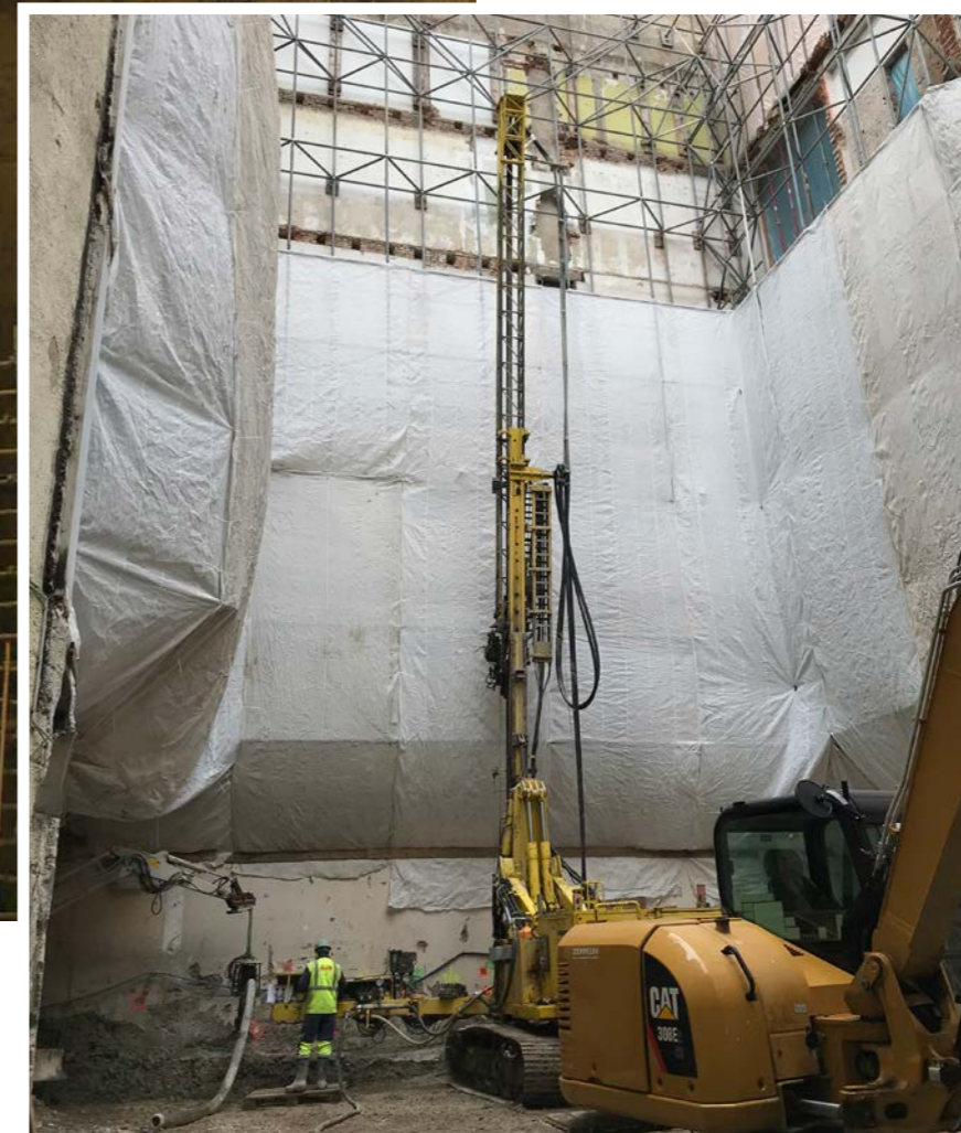
Die wasserdichte Unterfangung wurde im Düsenstrahlverfahren hergestellt
