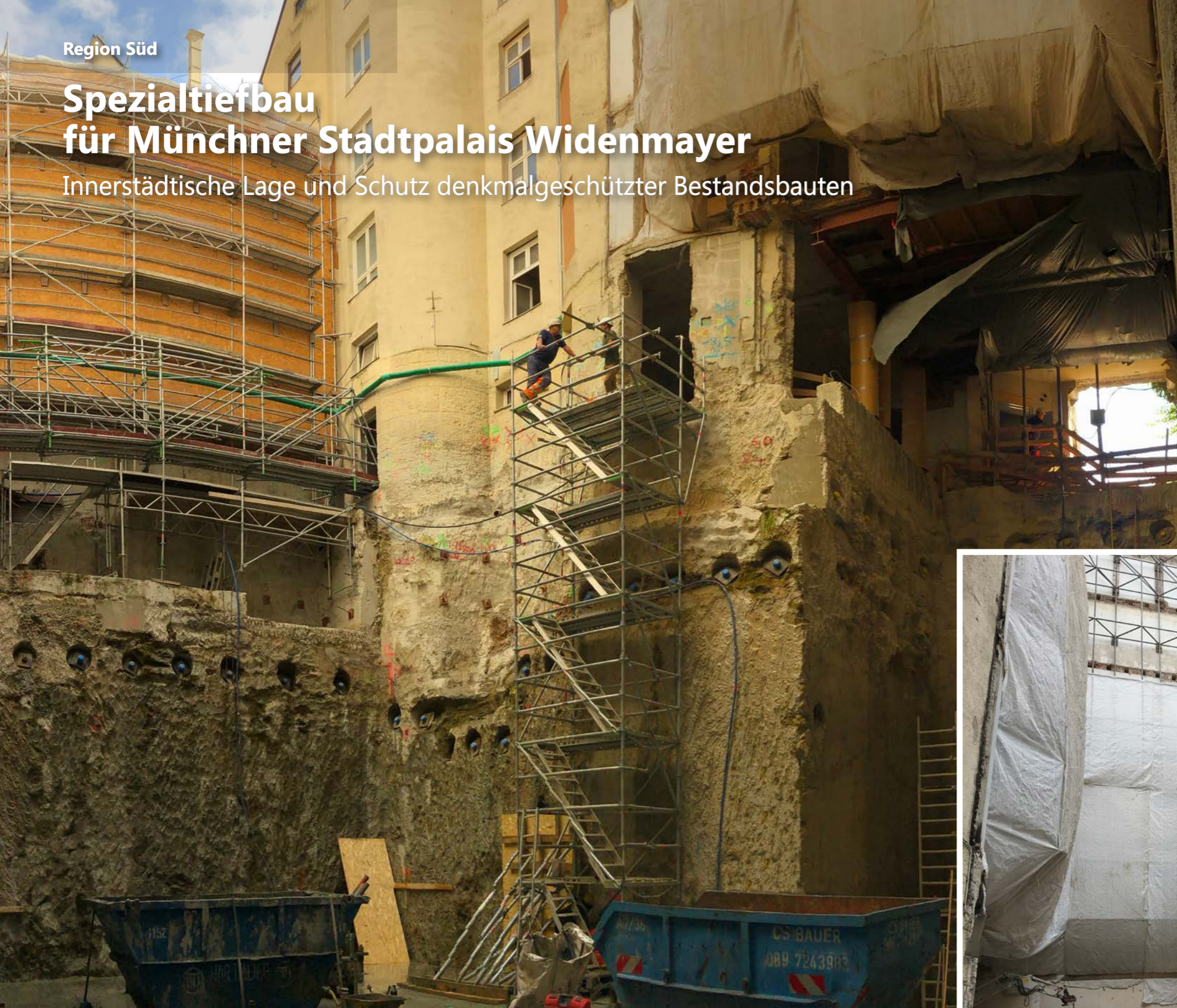
Die fertiggestellte Baugrube
