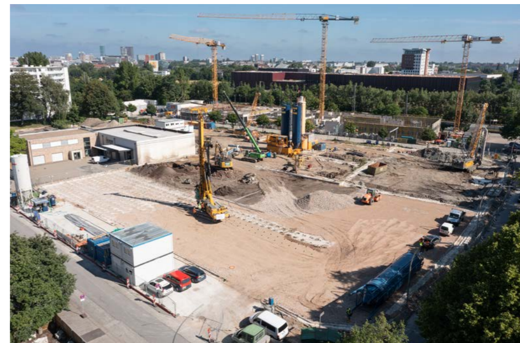
Blick auf das Baufeld
