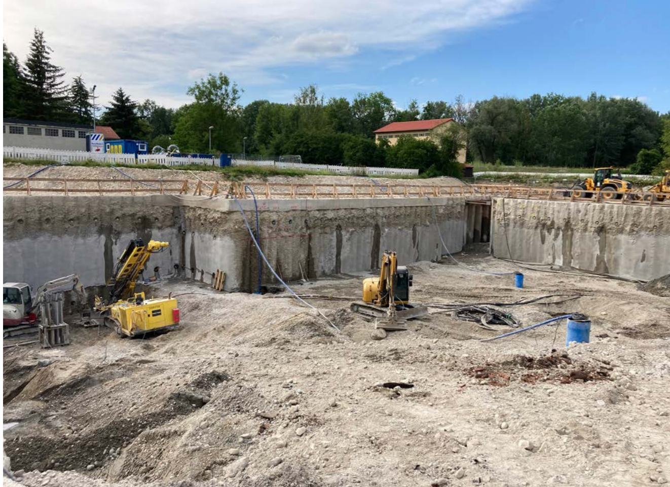
In Ingolstadt machte das hoch anstehende Grundwasser ein Abdichten der Sohle im DSV-Verfahren erforderlich.
