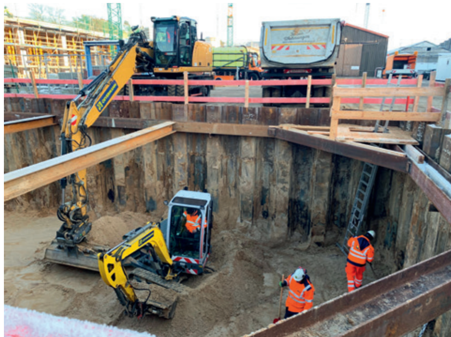
Die Aushubarbeiten der Baugrube von 17 m x 9 m mit einer Tiefe von 4,50 m erfolgten Hand in Hand mit Minibagger in der Baugrube und Mobilbagger oben.
