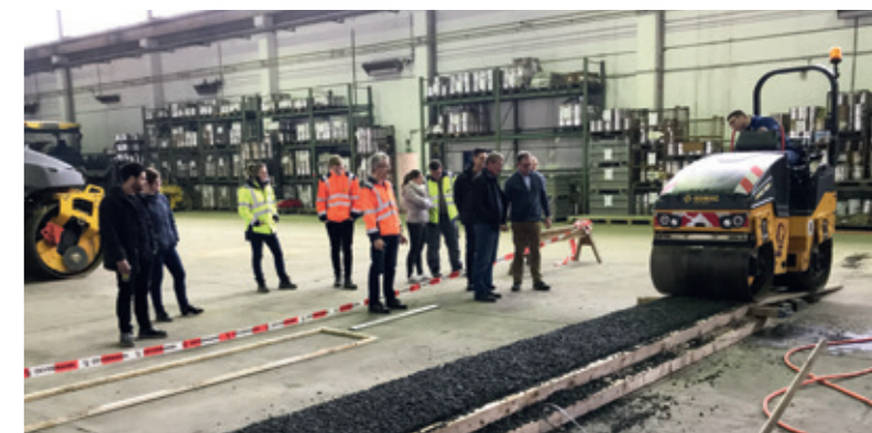
Die Weiterleitung von Niederschlägen in den Baugrund – mit fachlich richtig eingebautem Drainbeton ist die Entseigerung von Flächen möglich.
