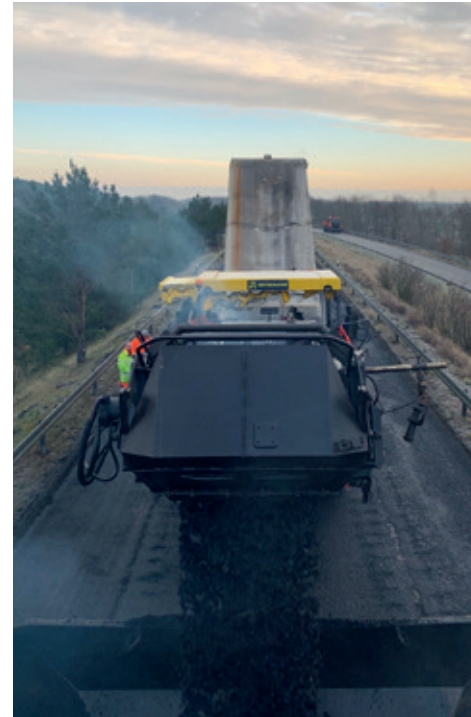
Der zweischichtige Einbau von Asphaltbefestigungen im Verfahren „Heiß auf Heiß“ ist eine besonders wirksame Bauweise, um langlebige Straßen herzustellen.
