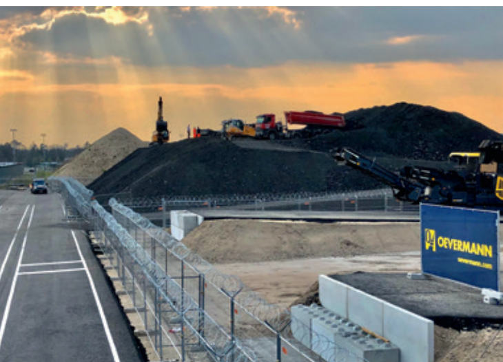
55.000 t Asphalt wurden auf einem Zwischenlager deponiert.
