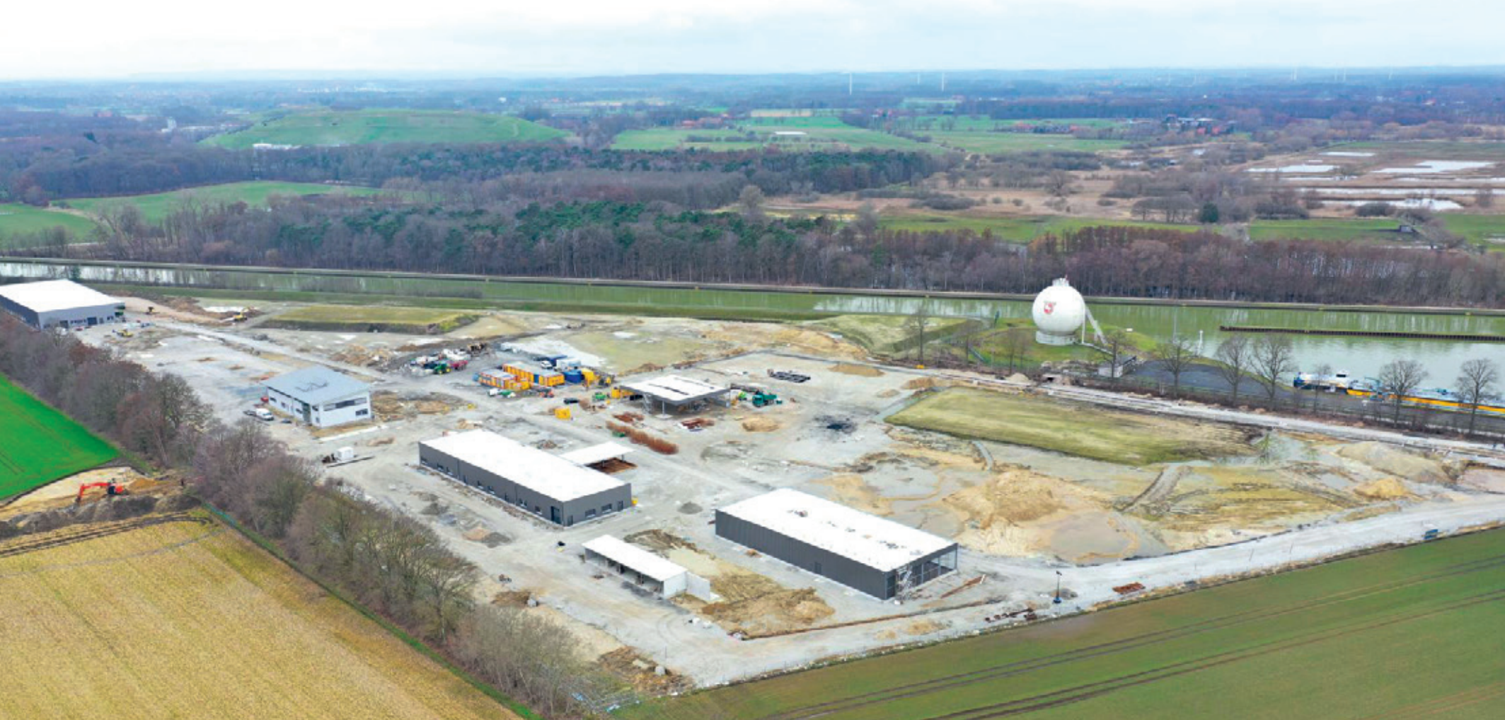
Die Baustelle aus der Vogelperspektive direkt am Dortmund-Ems-Kanal in Münster-Gelmer
