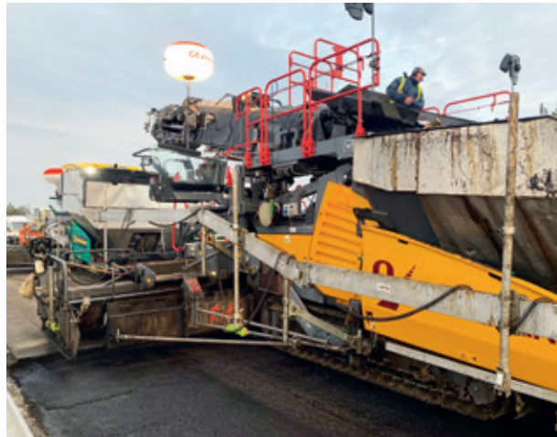
Der zweischichtige Einbau von Asphaltbefestigungen im Verfahren „Heiß auf Heiß“ ist eine besonders wirksame Bauweise, um langlebige Straßen herzustellen.
