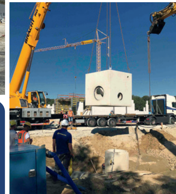
Einsatz eines Mobilkrans für das Versetzen des Schieberbauwerks
