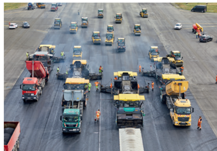
Nahtloser Einbau mit vier Fertigern
