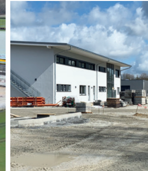
Das Sozial-/Betriebsgebäude mit Kantinenbetrieb für die Mitarbeiter des Werksgeländes der Westfalen AG.
