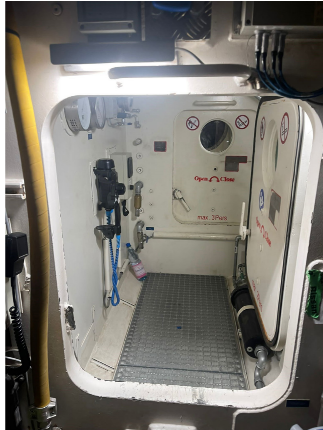
Einstieg in die Personenschleuse U5 Europaviertel
